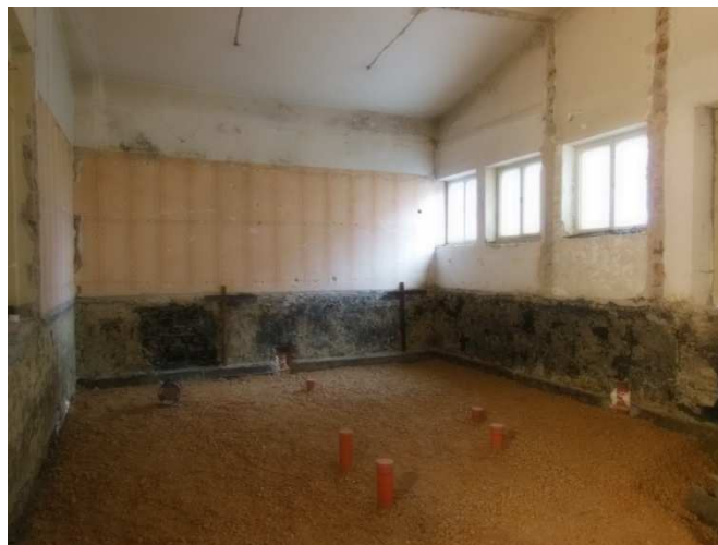
Práce na rekonstruovaném prostoru za výčepem
